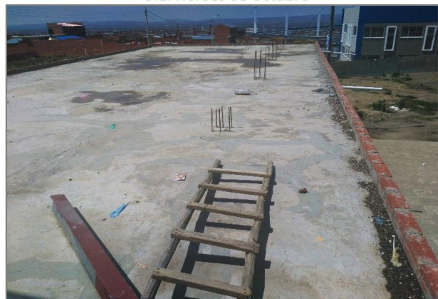
Imagen N° 3: Losa Superior de las Aulas Construidas en la U.E. Héroes de Octubre
