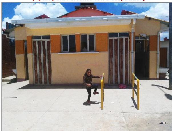
Imagen N° 4: Batería Sanitaria Construida en la U.E. España (Aptas para Personas con Discapacidad)
